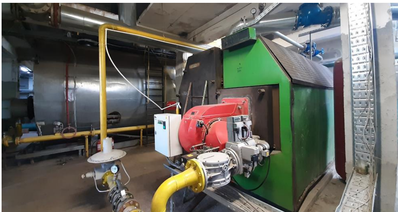
Fig. 6.d. CT4 Dorobanți: cazan HR3-3200, respectiv cazan 10 Gcal CIAF 10x15-00 (plan îndepărtat)
