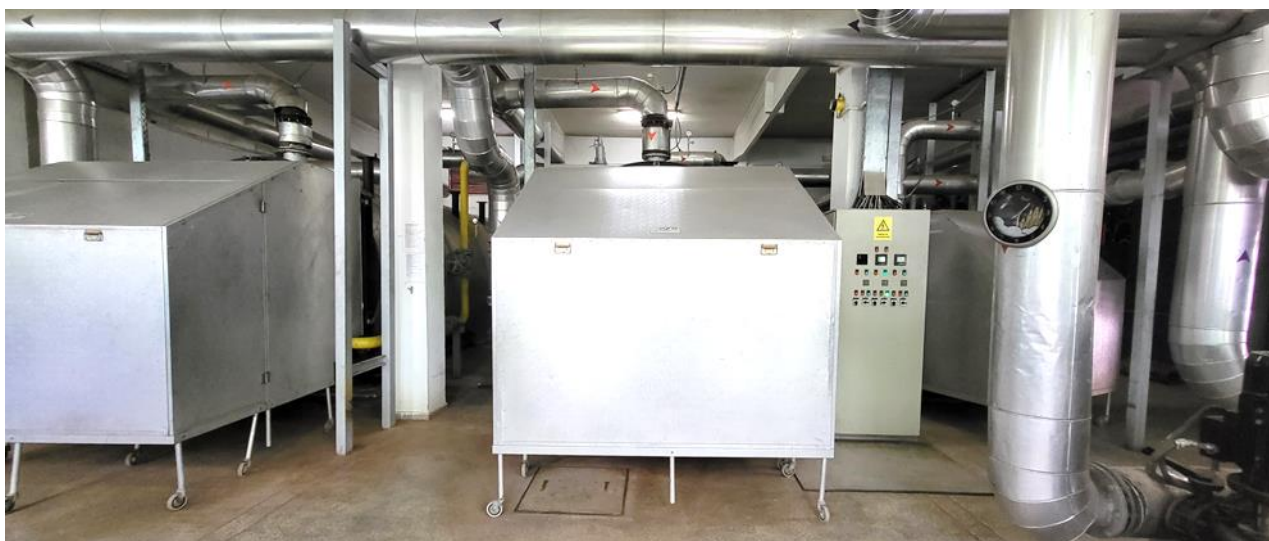
Fig. 6.b. CT3 Micro XIV. Cazane Ygnis Pyronox LD 6000 (stânga) și LR 2150 (dreapta) cu carcase termoizolante pentru reducerea pierderilor de căldură către mediul ambiant prin capacul frontal
